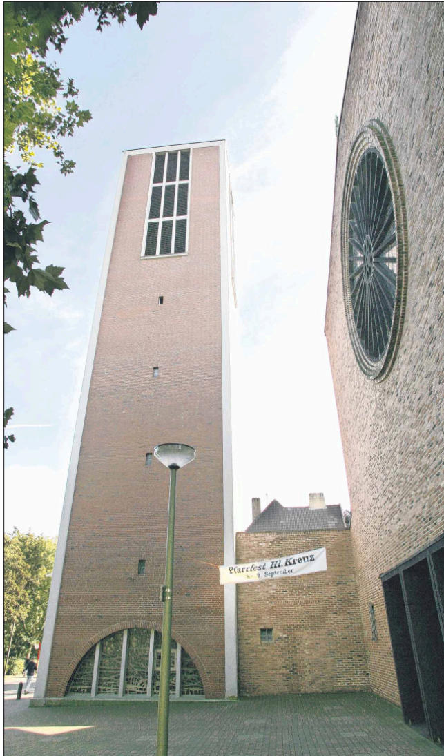
Der Turm der Heilig-Kreuz-Kirche wurde erst in den 1960er Jahren gebaut. Über dem Haupteingang der Kirche (rechts) ziert eine Rosette das Gebäude.
